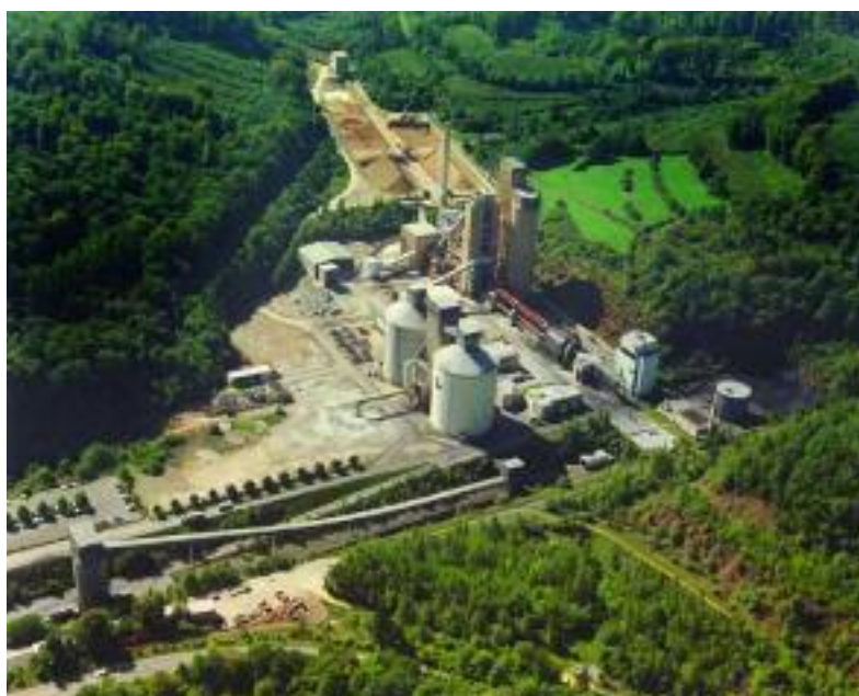
Rumelange, Lussemburgo: l'impianto di cottura visto dall'alto Rumelange, Luxembourg: view from the top of the clinker plant
