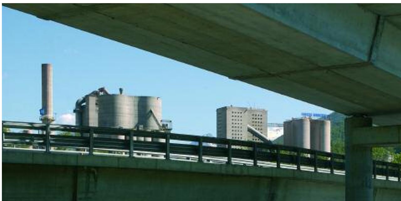
Scorcio della cementeria di Robilante, Italia A glimpse of the Robilante cement plant, Italy
